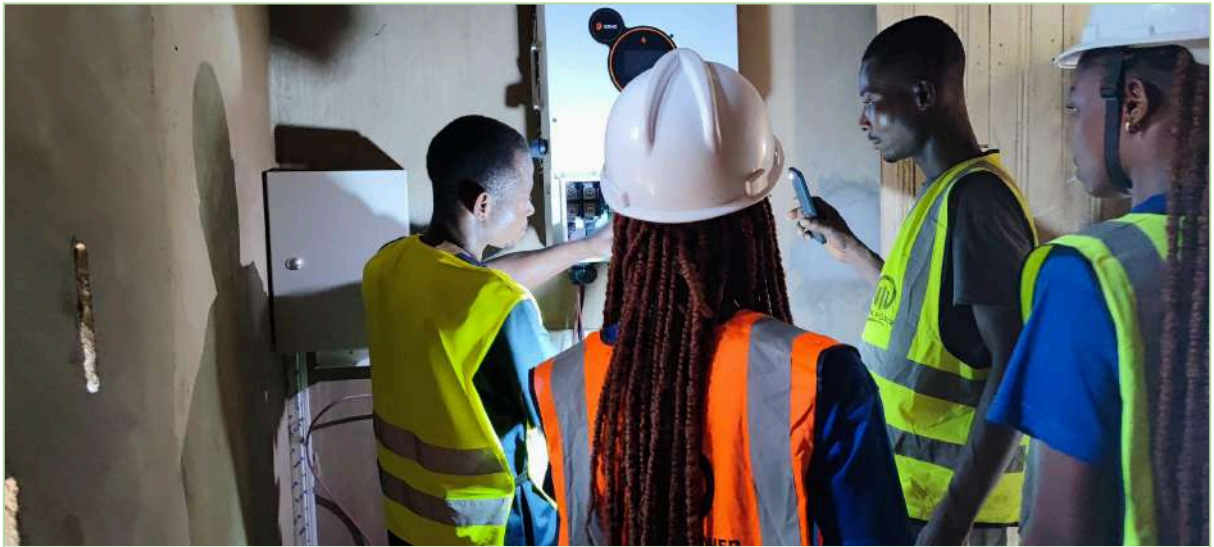
Img. 18 : Les YGG sur une installation solaire
