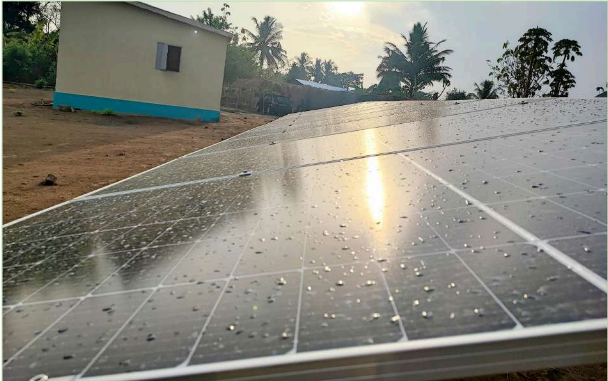
Img. 10 : Vue de façade du SPM
